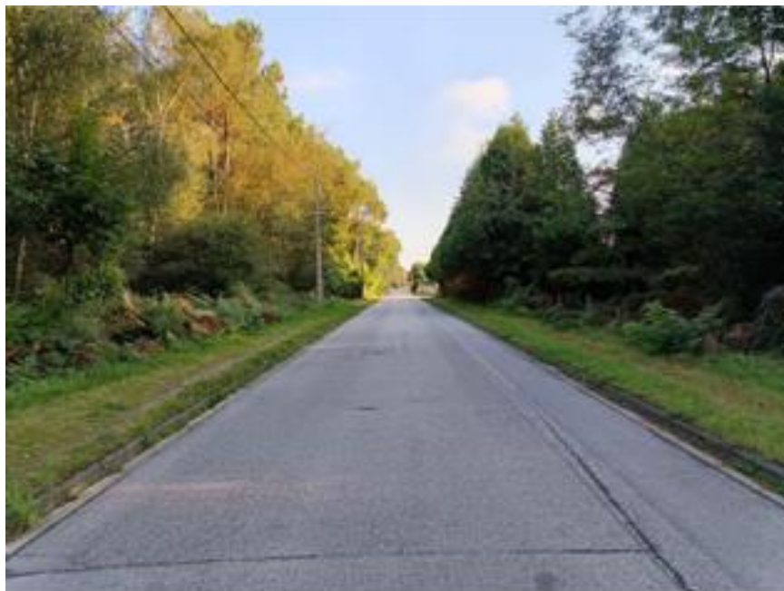
Aménagement de la route de Plesterven en voie verte jusqu'à la route de l'Université
