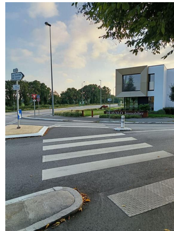
Traversée intersection du Pont de Vincin : trottoir abaissé, présence de BEV (BEV dans l'îlot de refuge aurait été intéressante)
