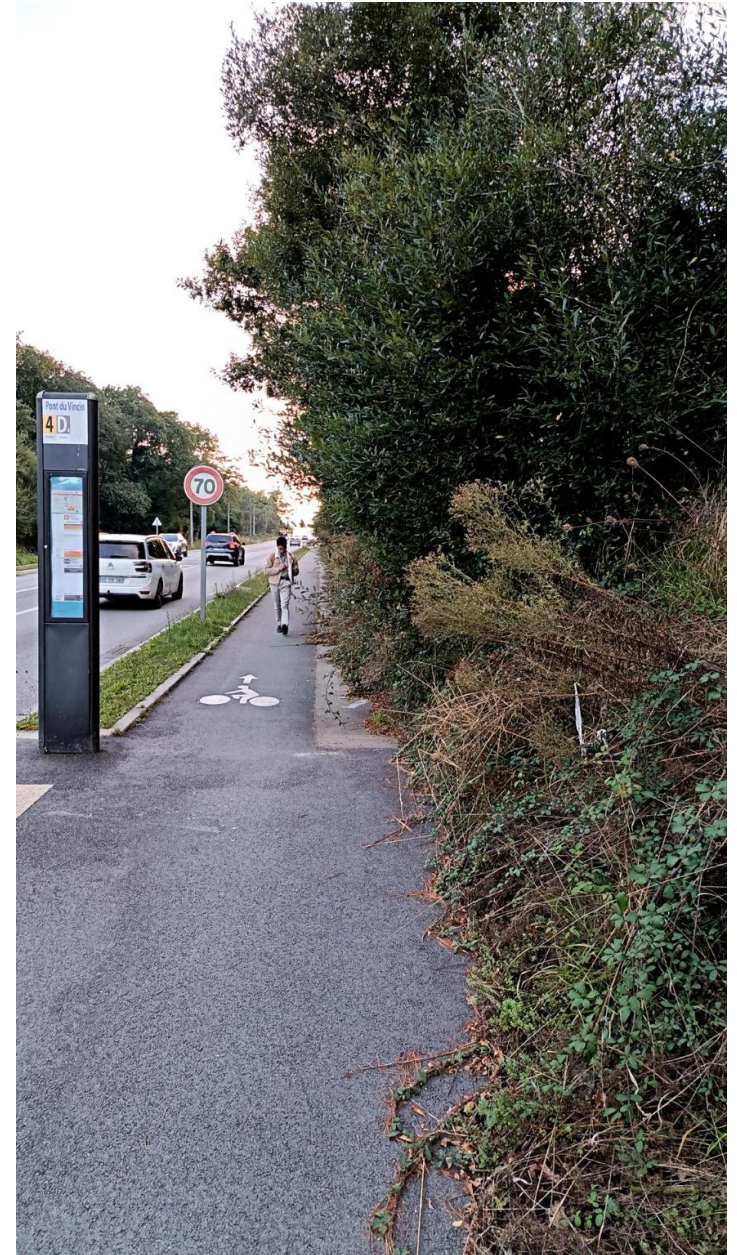
Problématique d'entretien sur la RD 101 - le cheminement piéton est envahi par la végétation
