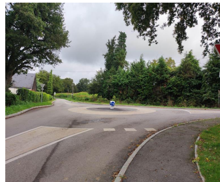
Giratoire de Lanneguen avec des rayons de giration et des hauteurs de bordures inadaptés aux engins agricoles
