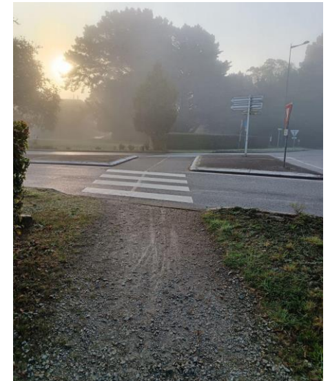
Giratoire de la Brèche : absence de BEV, revêtement gravier
