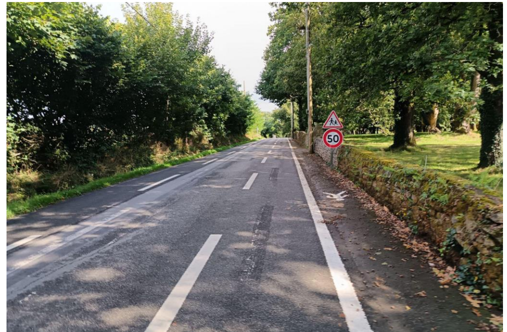
Marquage au sol du chemin + chaucidou rue de Cadic Un chemin piéton vers le collège peu sécurisant
