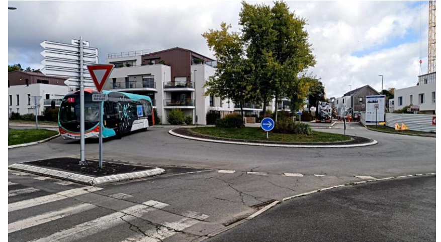
Giratoire de Botquelen : marquage dégradé, absence de BEV
