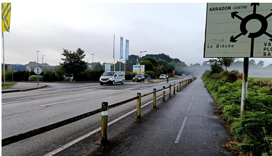
Un tourne à gauche et une insertion difficile à la Brèche pour quitter ou rejoindre la V45 depuis et vers le quartier de La Brèche et les commerces
