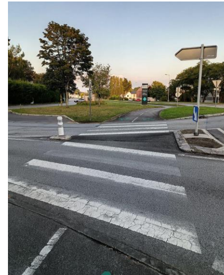
Giratoire de Botquelen : marquage dégradé, absence de BEV
