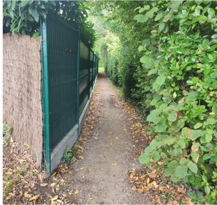
Chemin au départ de la rue Men Gwen Largeur inférieure à 1,4 mètres, absence d'éclairage
