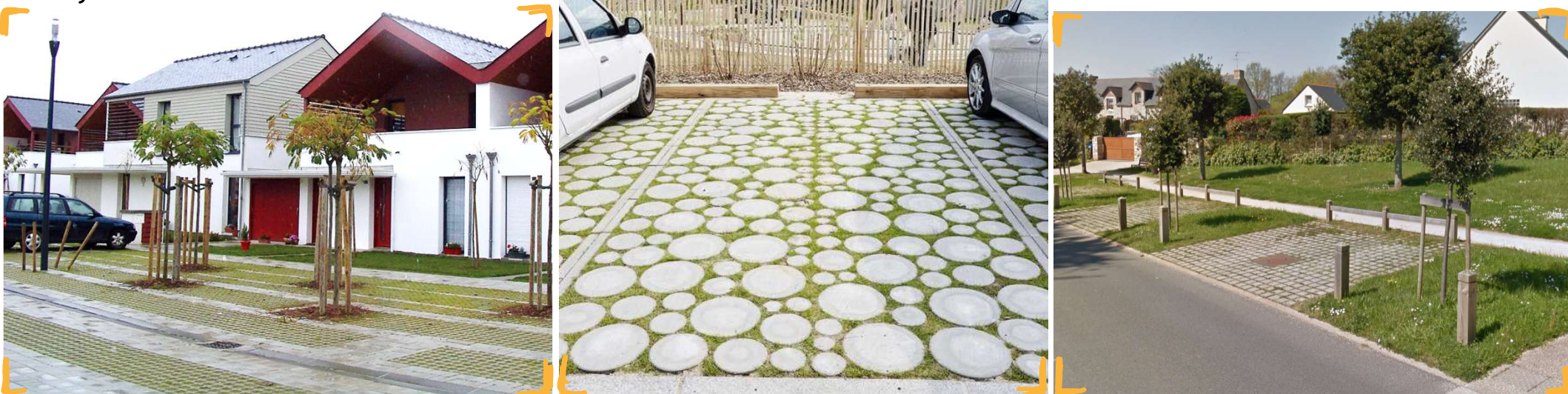
Pavés à joints enherbés :
