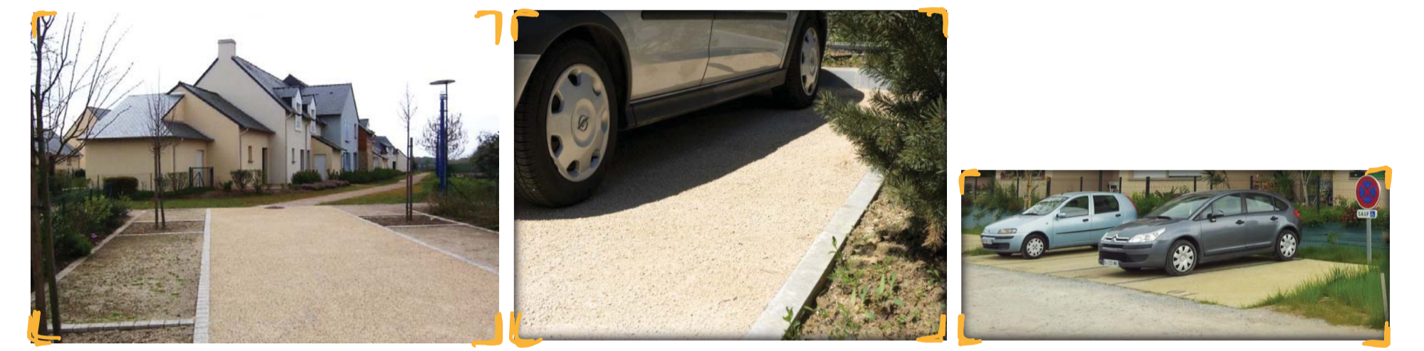
Dalles enherbées ou dalles gravillonnées :
