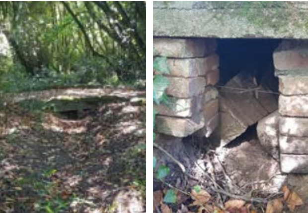
C- Ouvrage de franchissement vieillissant à remplacer
