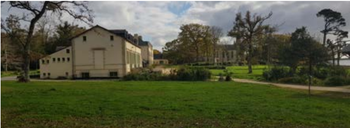
Source : Photo de l'état actuel de la prairie en direction des bâtiments Rencontre et Habitation
