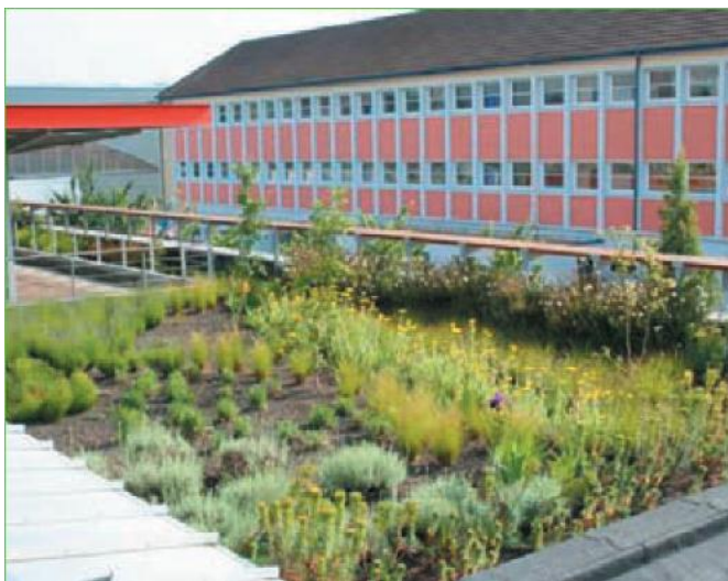
Toiture stockante végétalisée
