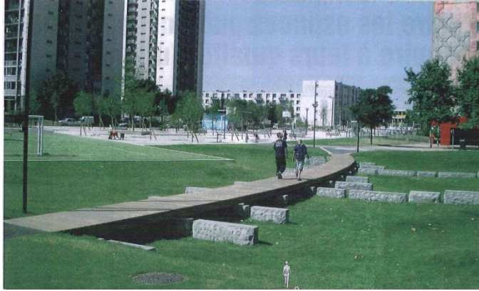
Bassin tampon paysager
