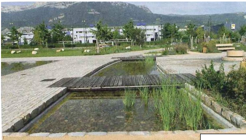
Bassin tampon paysager
