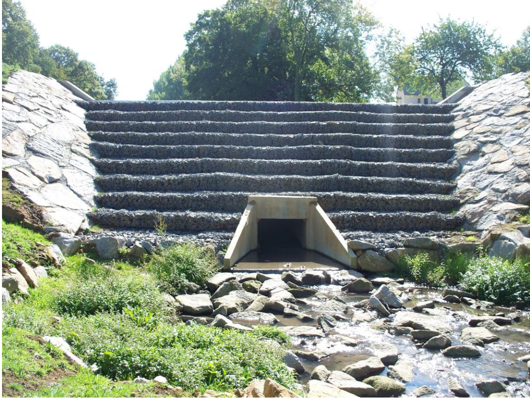
Déversoir en Gabions de forme escalier
