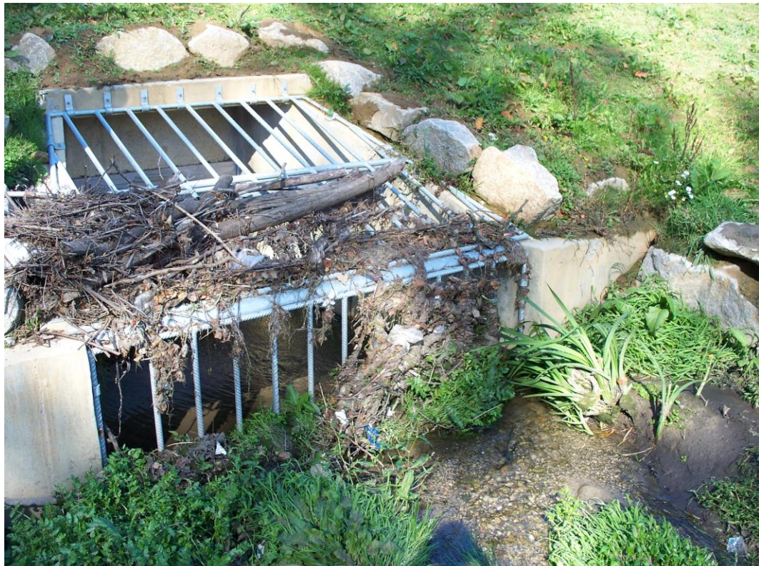
Ouvrage de fuite coté amont du barrage
