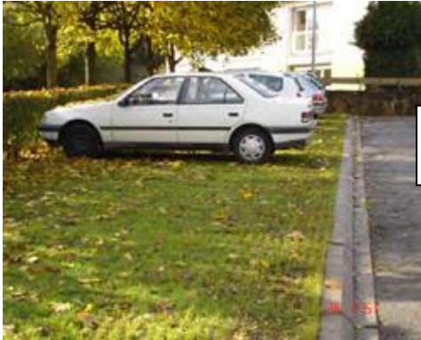
Parking engazonné perméable
